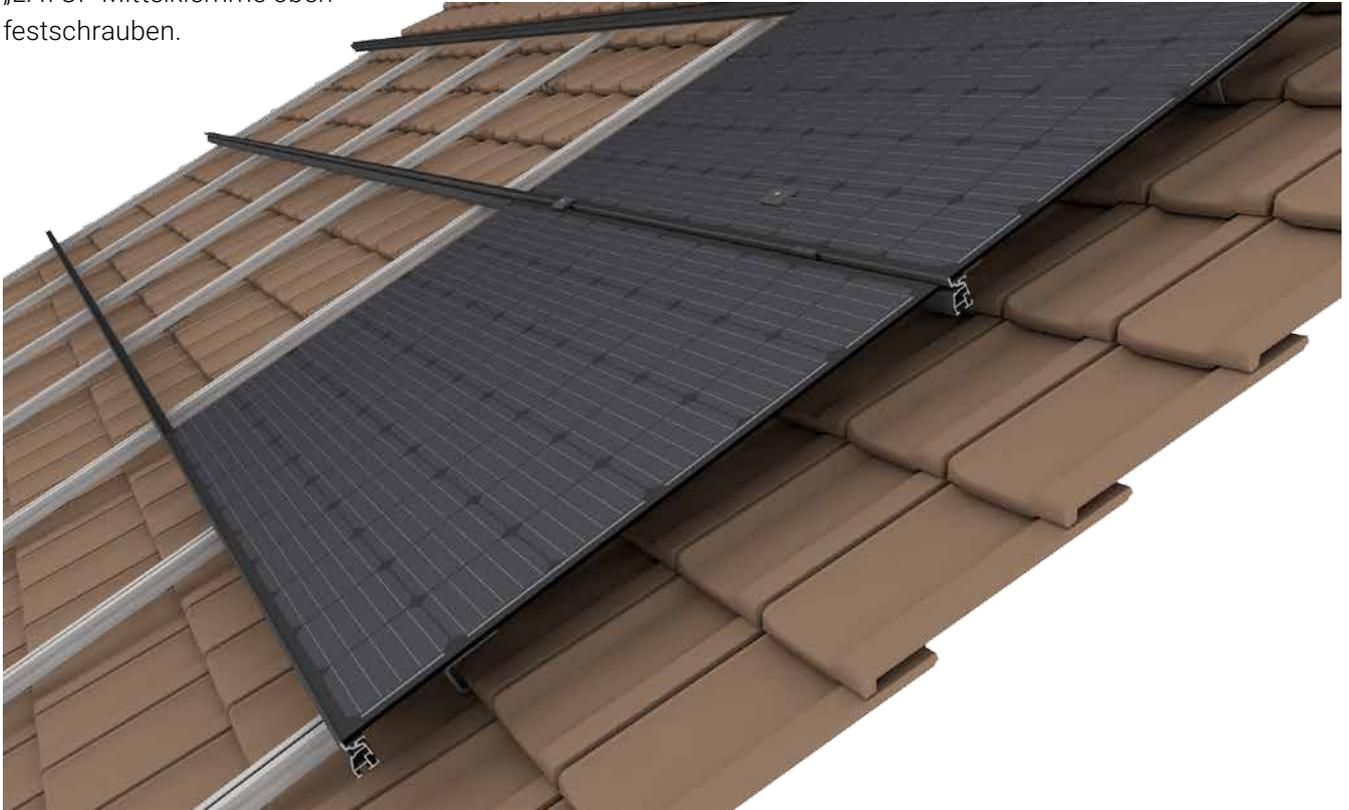
Nächste Module platzieren und sichern. Zwischen den Modulen die „LAYUP Distanzhalter“ einlegen. Die unterste Reihe wird mit der „LAYUP Endklemme“ gesichert.
