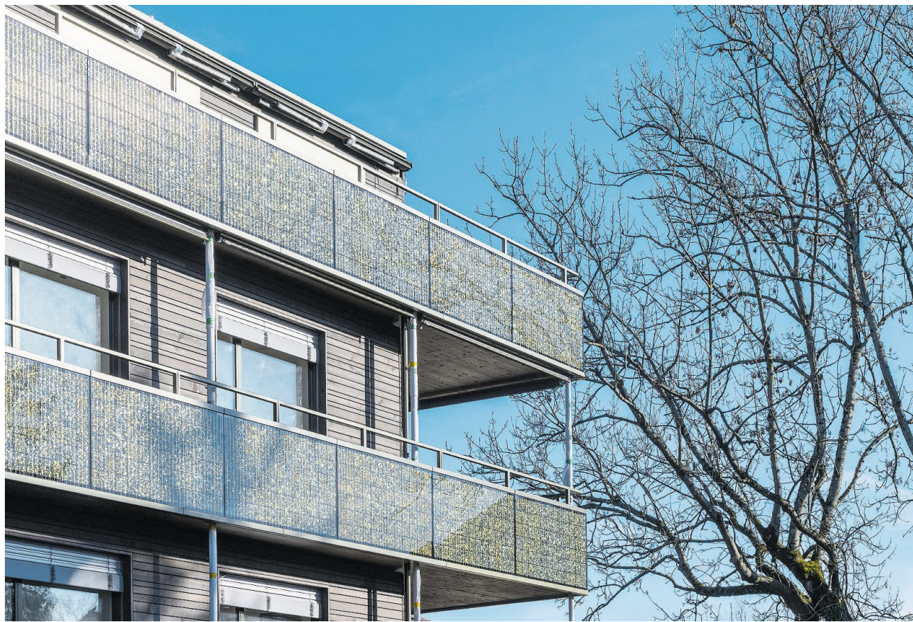
Photovoltaikmodule dienen als Brüstungen und geben dem Gebäude Glanz.
